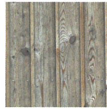
Bardage à couvre joints
